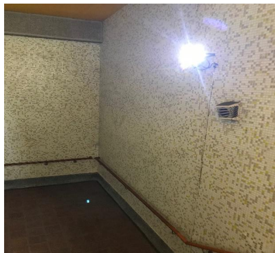
節能燈具，樓梯間更換為 LED 感應式照明燈
